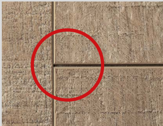
Herkömmlicher Vinylboden mit thermoplastischem Kern und offener Fuge
