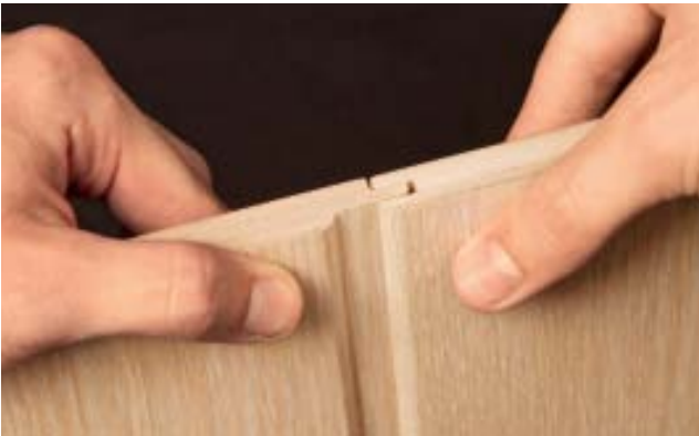
Nut-Feder-Paneel mit sichtbarer Feder
