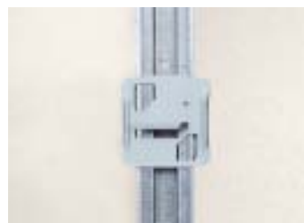
Klipp entlang der Schiene verschieben.
